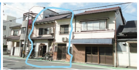
before写真。狭小地でのマンション建設が分かる
