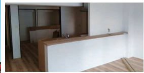
内装工事が進む「リラス東公園」。写真はリビング
