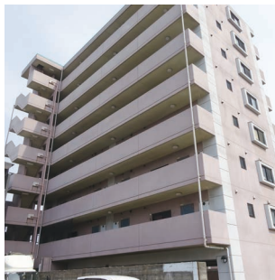
大規模修繕工事前の「FTN 空港通り」 (Before)
